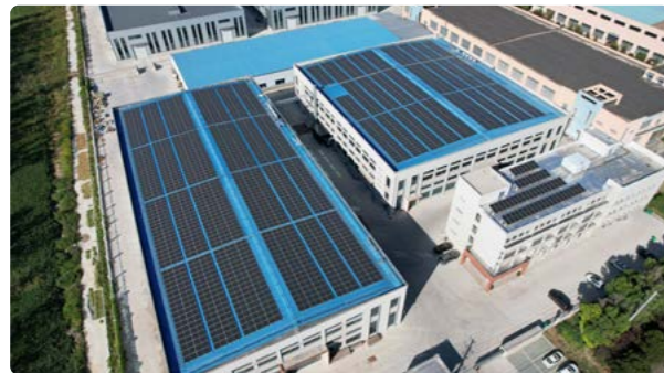
○ 江苏俊达 1.8 MW 分布式光伏发电项目， 预计年发电量 198 万度
